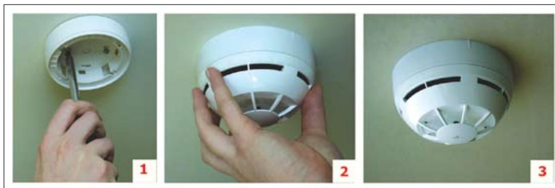
Рис. 2 Установка в помещении одного радиоканального адресно-аналогового пожарного извещателя занимает всего несколько минут
